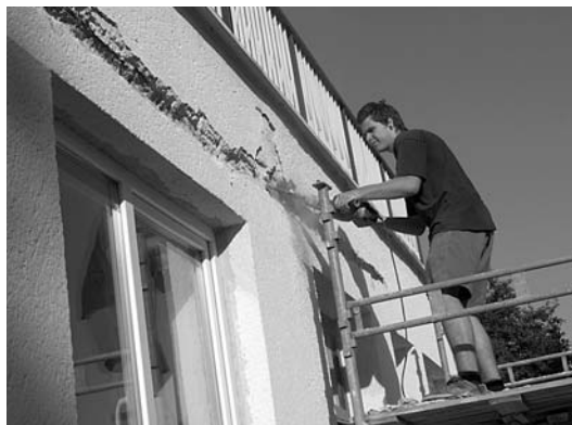
Přeložku telefonního kabelu bylo nutné umístit do omítky budovy MŠ. Práci se zhostily Služby města. Foto: Karolína Bártová
